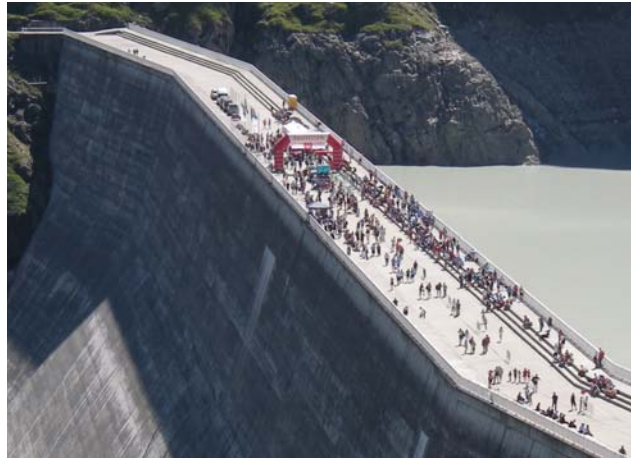
Arrivée sur le barrage de la Grande Dixence
